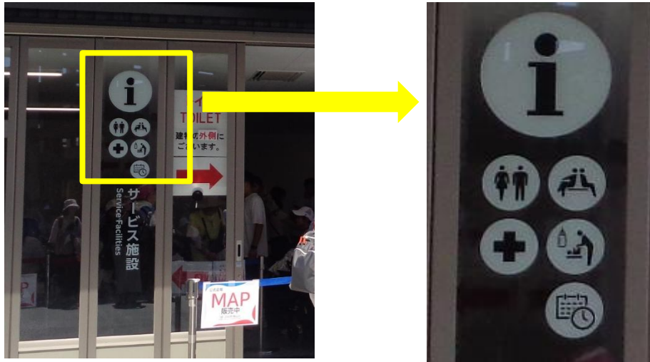
写真9. カームダウンスペースがあることを示すピクトグラムが描かれていない (サービス施設北東内)
