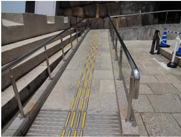
写真 8. スロープ上に設置されている点字ブロッ ク：要改善事例 大阪城（大阪）
