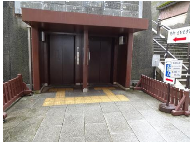
写真 9. エレベータの出入り口前の全面に設 置されている点字ブロック：要改善 事例 成田山新勝寺（千葉）
