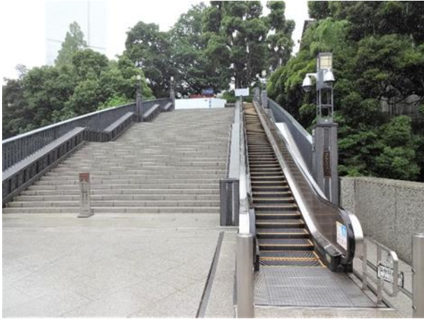
写真4. 上りエスカレーターのみ設置されている： 要改善事例 日枝神社（東京）2020年 6月調査時点 ※現在は下りエスカレーターも設置済
