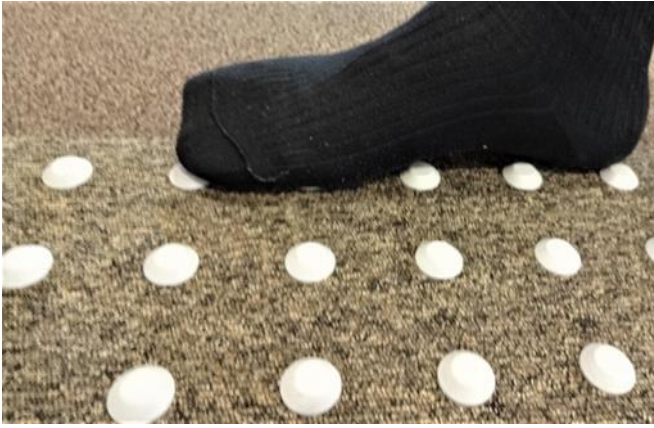
写真 12. 靴を脱いで上がる館内に屋外用の点字ブロックを設置している 2：要改善事例 三十三間堂（京都）
