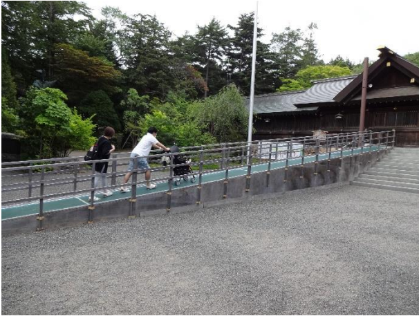
写真 2. スロープの角度：好事例 北海道大神宮（北海道）
