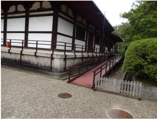
写真 6. 景観に配慮したスロープ：要改善事例 唐招提寺（奈良）
