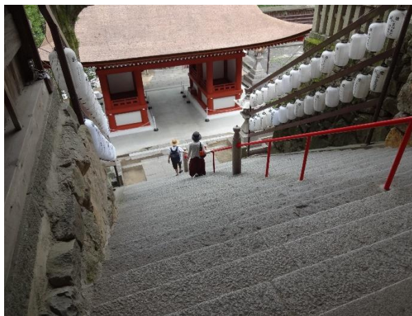
写真 16. 階段の手すり：要改善事例 吉備津神社（岡山）
