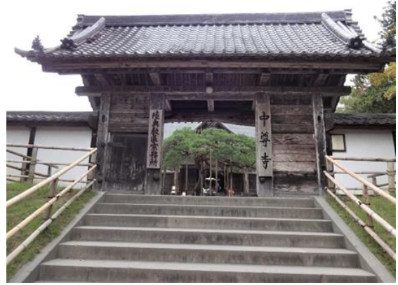
写真 23. 階段の手すり：要改善事例 中尊寺（岩手）
