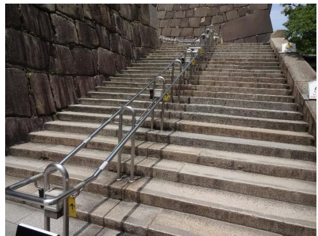
写真 17. 階段の手すり：好事例 大阪城（大阪）
