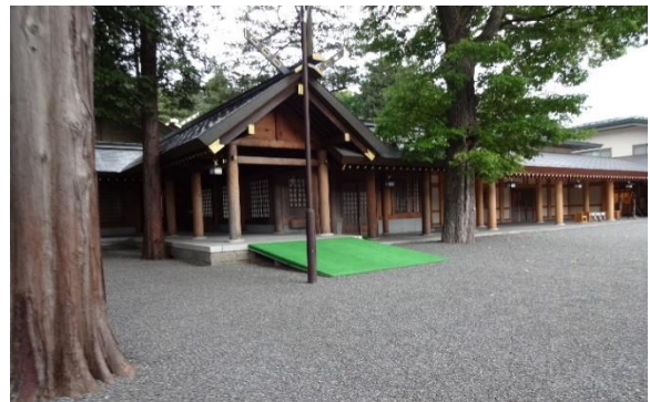
写真 4. 景観に配慮したスロープ：要改善事例 北海道大神宮（北海道）
