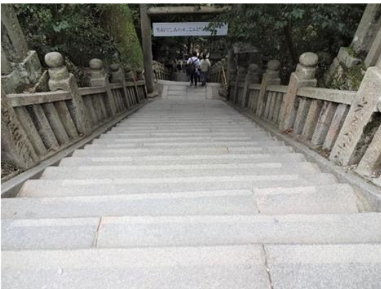
写真 26. 段差の縁：好事例 金毘羅宮（香川）
