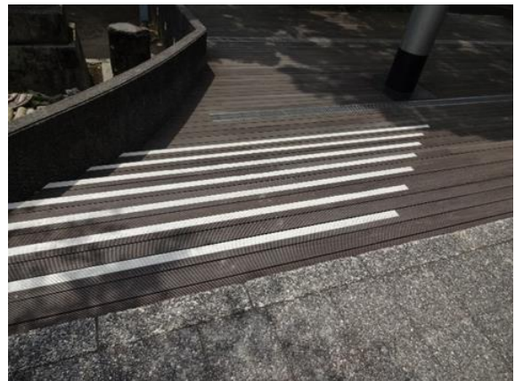
写真 25. 段差の縁：好事例 太宰府天満宮（福岡）
