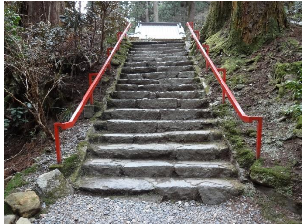
写真 15. 階段の手すり：好事例 御岩神社（茨城）
