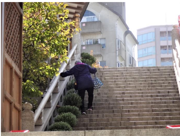
写真 20. 階段の手すり：要改善事例 湯島天神（東京）
