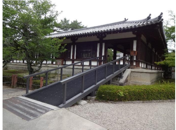
写真 3. スロープの角度：要改善事例と好事例 法隆寺（奈良）
