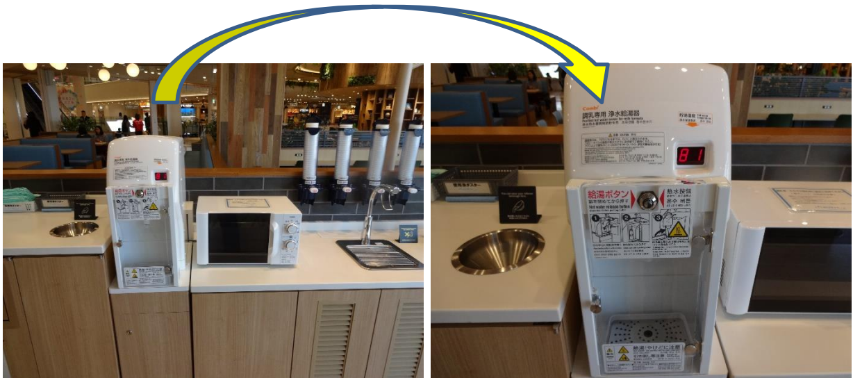
写真 18. 粉ミルクをつくるための給湯器。81 度に設定されているため、すぐに調乳することができる
