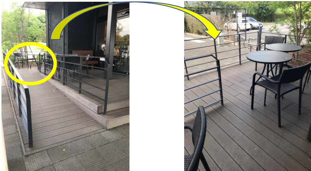
写真 1. スロープの先にテーブルが設置されているために、結果的に車いす使用者はスロープを利用して店内に入ることができない
