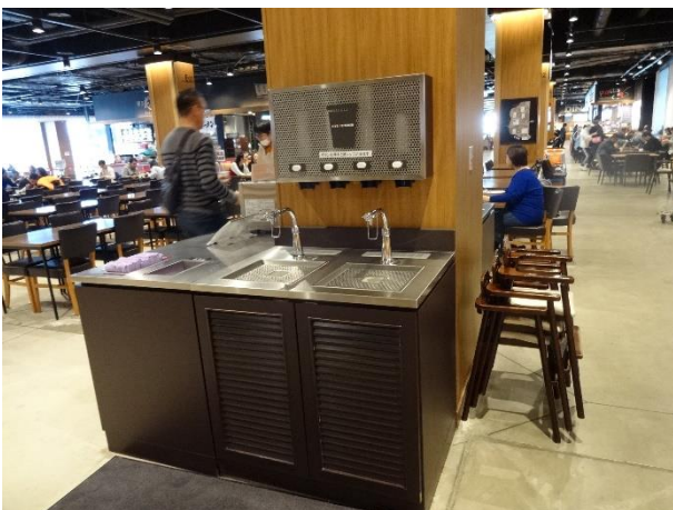
写真 22. コップの位置が高く、遠いために車いす使用者は利用できない
