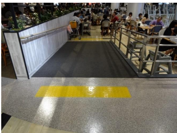
写真 2. スロープの始終に設置されている点字ブロックは車いす使用者にとって、移動のバリアになるだけでなく、視覚障害者もその部分への設置を望んでいない
